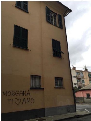
Figura 4.1 - Particolare della porzione di involucro
