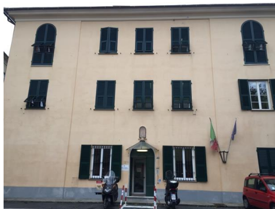
Figura 1.1 - Vista della facciata esposta a Nord - Ovest
