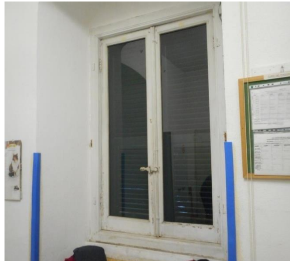
Figura 4.4 - Particolare dei serramenti
